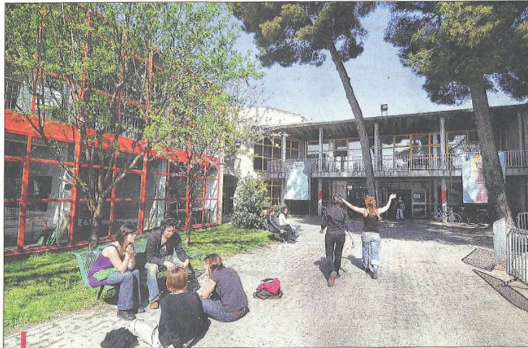
Le bâtiment n'est plus aux normes et sa réhabilitation est estimée selon certaines sources à 4M€. / PHOTO ARCHIVES SOPHIE SPITERI
