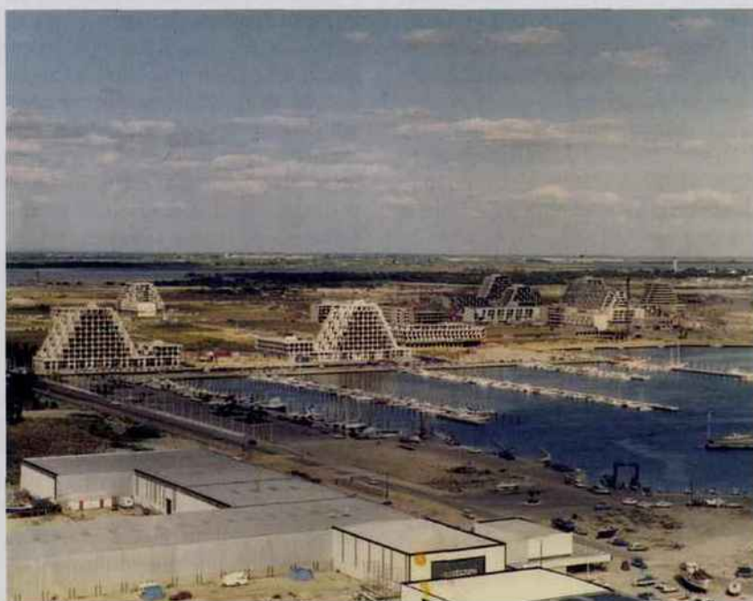
Les « palais mayas » en cours de construction en 1969.
